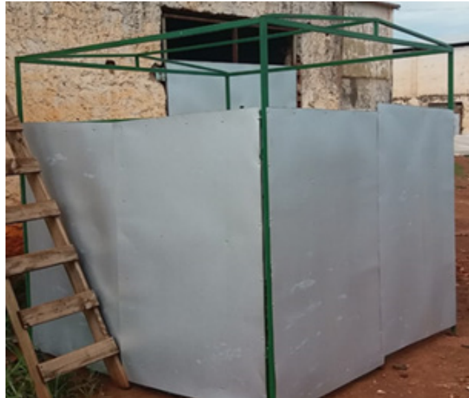
Figura 2: Estrutura metálica, composta de zinco e alumínio, utilizada para a fabricação do Pontos de Entrega Voluntária PEV.
