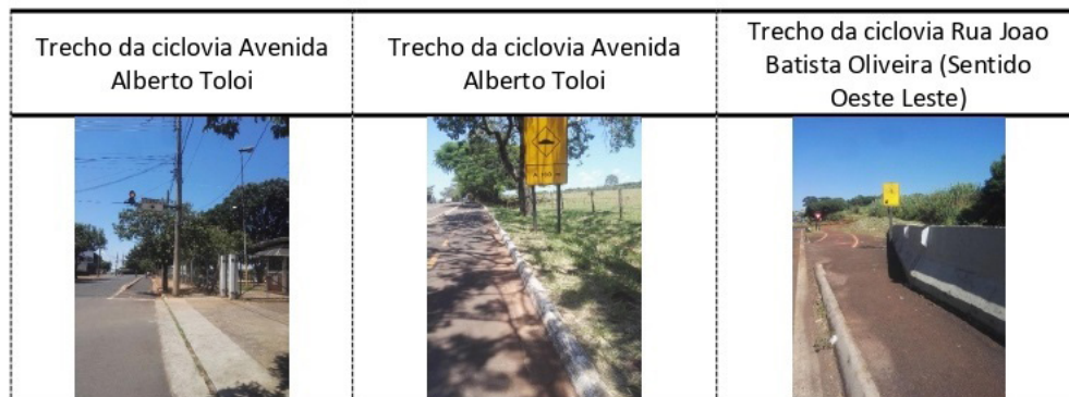
Figura 8: Indicador “Condições de Sinalização (CS)”
