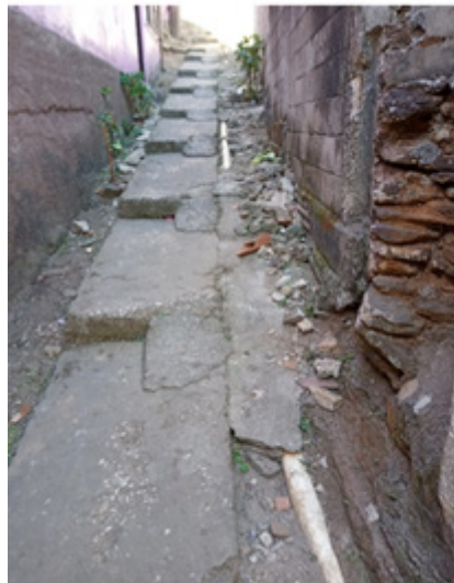
Figura 6 – (A) Tubulação de esgoto exposta (B) Tubulação de água exposta
