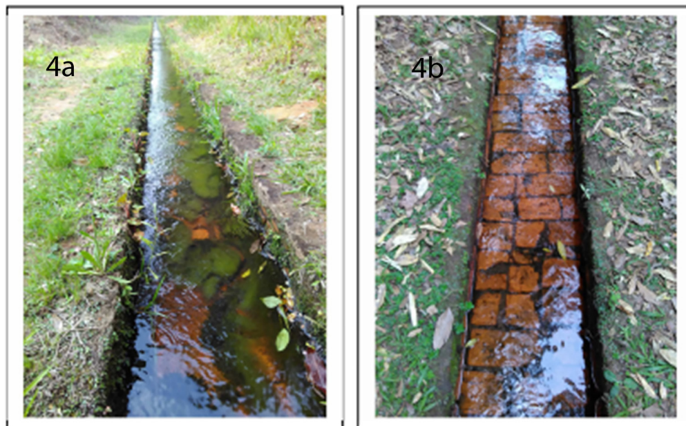
Figura 4. Imagem do sub-trecho de montante (4a) e sub-trecho de jusante (4b).
