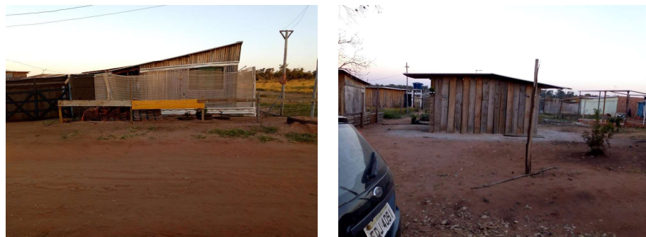
Figura 1: Casas construídas em madeira para abrigar famílias no Nova Canaã.
